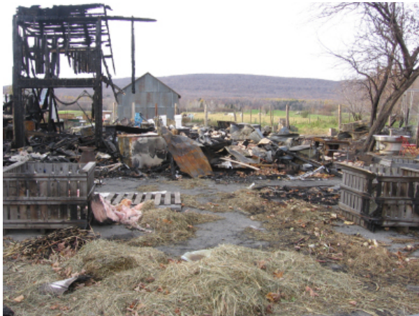
Les dégâts causés par l'incendie
